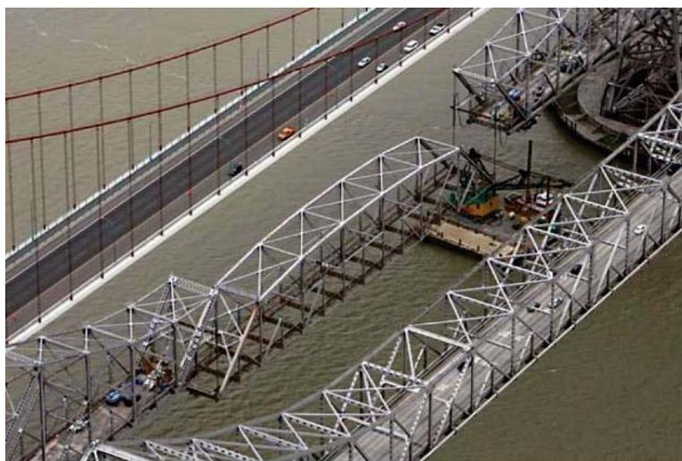
Figure 20 – Descente de la travée suspendue du pont Carquinez
