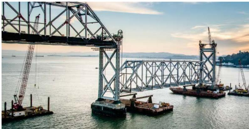
Figure 21 – Le pont Oakland Bay à San Francisco – Dépose d'une travée de 504 pi (source : avec la permission de Foothills Bridge Co (photo de Sam Burbank))
