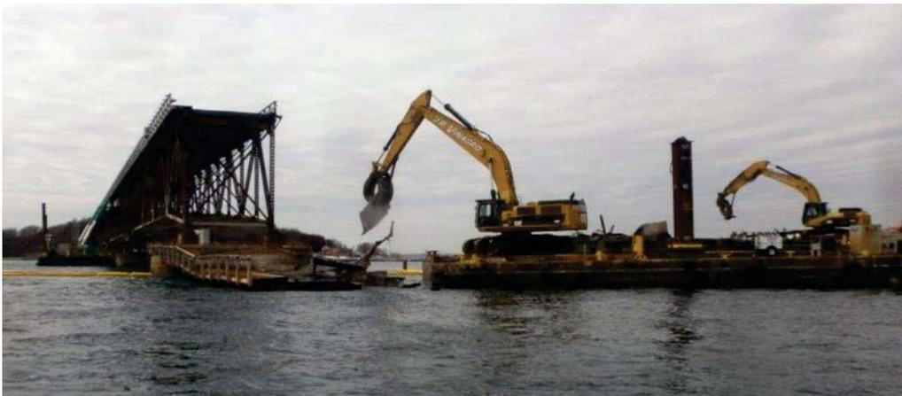
Figure 25 – Travaux de démolition par méthode conventionnelle sur barge pour le pont de Long Island au Boston Harbor (source : Walsh Construction 2016)
