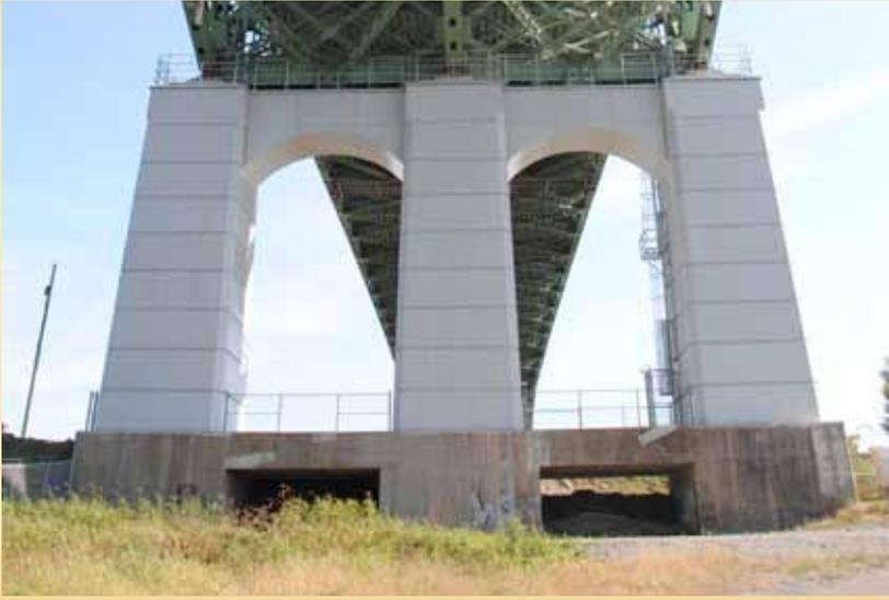
Pour la première fois au pont Champlain à Montréal, un coffrage d'acier permanent a été installé dans le cadre de la réfection d'une pile sous le tablier du pont.
