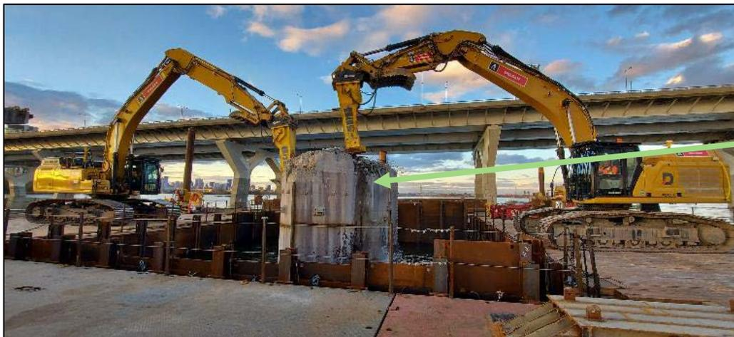
Déconstruction de piles (au-dessus de l'eau) et semelles (sous l'eau)
